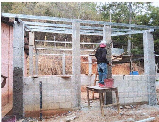
Foto 1: Mejoramiento con estructura tipo pórtico e instalación de lámina troquelada calibre 26 de la cocina en proceso
