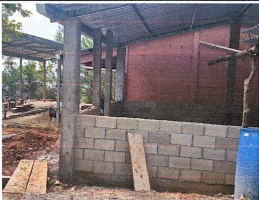
Foto 3: Mejoramiento con estructura tipo pórtico e instalación de lámina troquelada calibre 26 de la cocina en proceso
